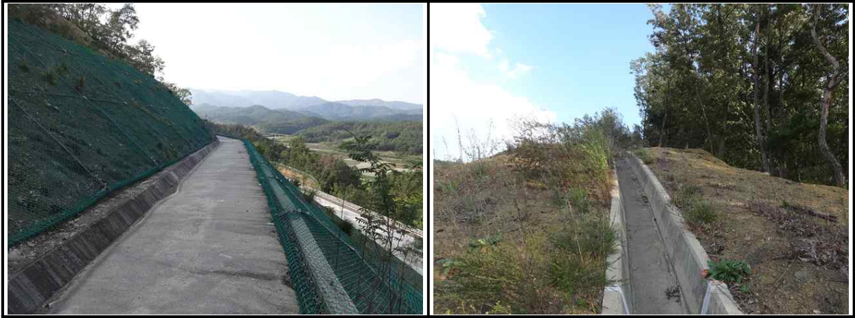
【그림 52.3.3】 배수시설 전경
