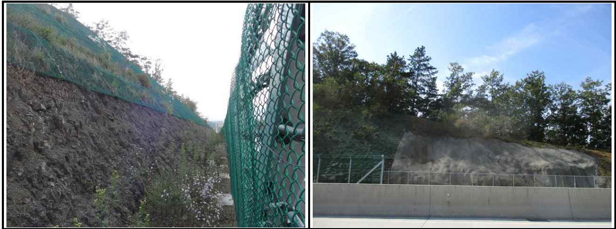
【그림 52.3.4】 보호/보강시설 전경
